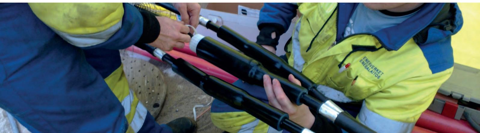
Подземные кабельные линии практически не требуют обслуживания и имеют длительный срок службы. Решения Ensto для подземных распределительных сетей включают в себя функциональные и надежные аксессуары среднего напряжения с технологиями термо- и холодной усадки. Более того, наши гибридные соединения и заделки представляют собой эффективное и долговечное сочетание обеих технологий. Продукция прошла испытания в соответствии с международными стандартами.
